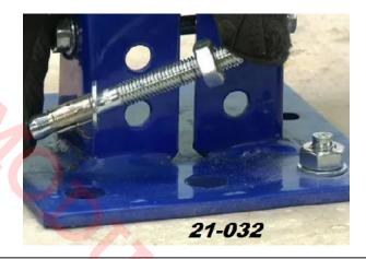
Hacer barreno de 3/8" diámetro, el ancla debe entrar a presión sobre el hueco. Colocar la tuerca hexagonal unos 3 mm debajo de la clavija de introducción del taquete). Meter el taquete con ayuda de un martillo. Después apretar la tuerca en sentido horario, el perno cónico se introduce automáticamente en el gancho de expansión y se expande en la pared del agujero de concreto.
